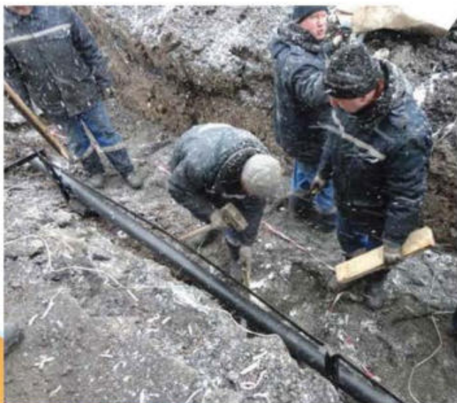
ТУГРЭС. Строительство кабельной канализации, прокладка кабеля. 2012 г.
