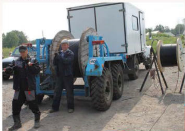
Протяжка кабеля. Монтажники М. П. Пьяных и А. В. Осипов
