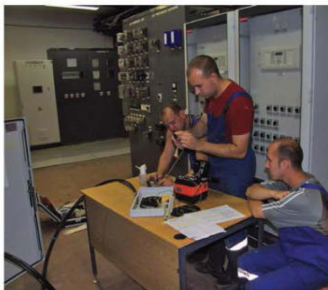
Подстанция 220 кВ Означенное. Сварка оптического кросса. Саяногорск. 2011–2012 гг.
