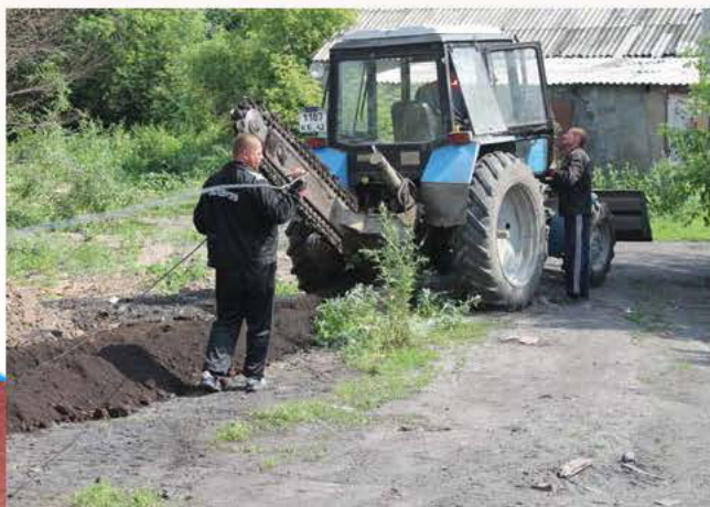
Подготовка траншеи и прокладка кабеля в грунт
