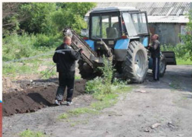
Подготовка траншеи и прокладка кабеля в грунт
