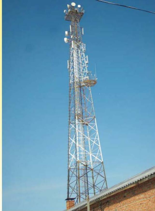
Строительство радиорелейной линии связи
