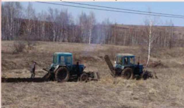
Рытье траншеи для прокладки кабеля в грунт
