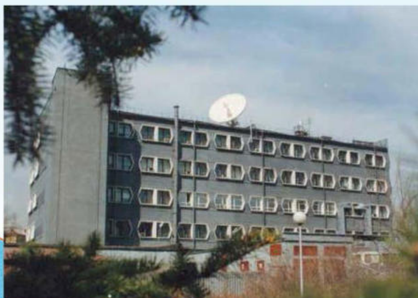
Здание Новокузнецкой телеграфно-телефонной станции
