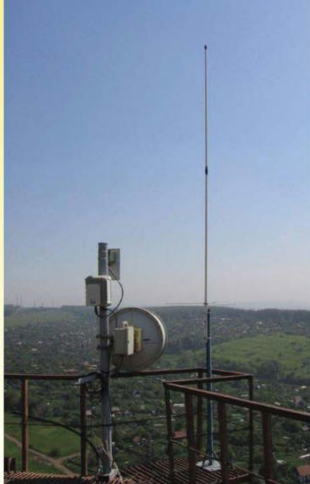
Монтаж антенно-фидерного устройства на АО-97 ПС «Кузнецкая»
