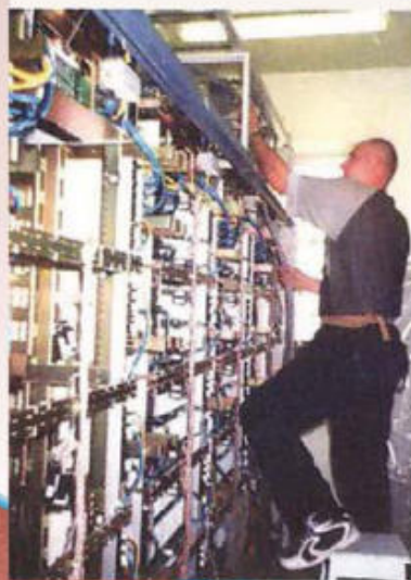
Монтаж оборудования СС-08. Благовещенск
