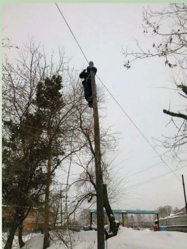
Монтажник кабельной сети
