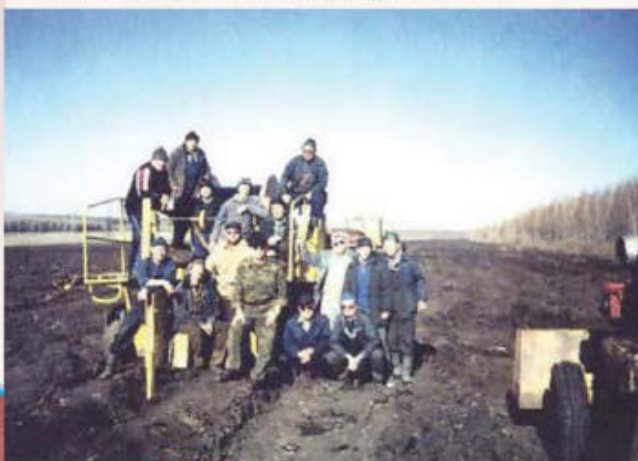
Работа мехколонны по прокладке ВОЛС Аткарск – Етцацево, 2002 г.
