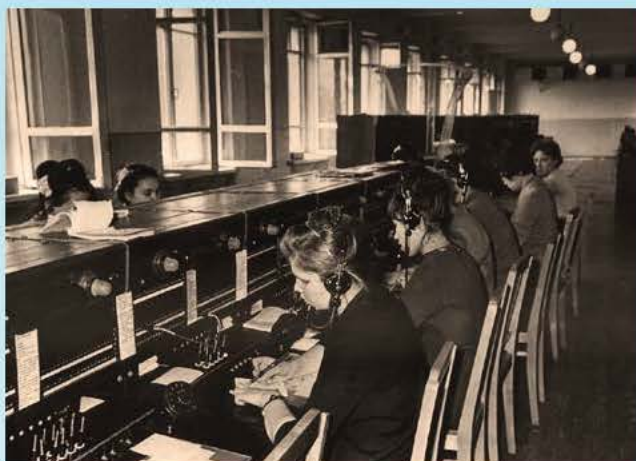
Коммутаторный зал МТС Кемерово
