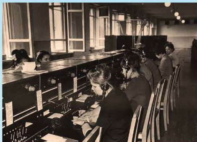
Коммутаторный зал МТС Кемерово
