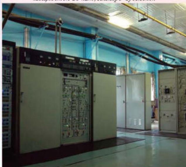
ТВ-станция «Зона-2», Ленинск-Кузнецкий
