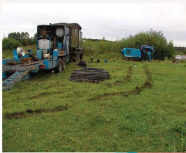
Работа установки ГНБ
