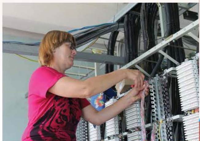
Настройка аппаратуры. Т. И. Кошелева, монтажница связи
