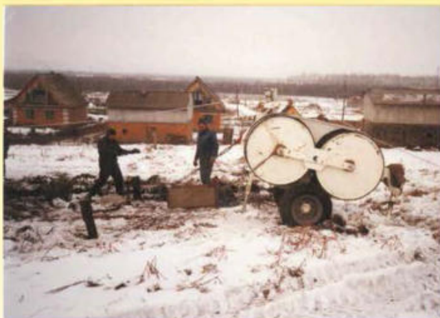
Строительство ВОЛС. 1995–1996 гг.
