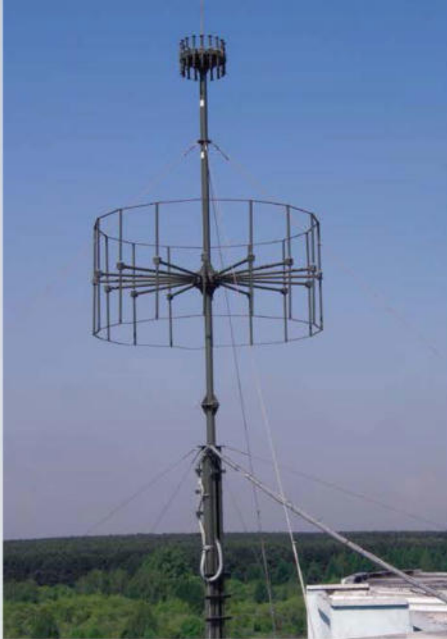
Монтаж стационарного комплекса радиоконтроля «ТМО-2С8» («Навигатор») в Белове
