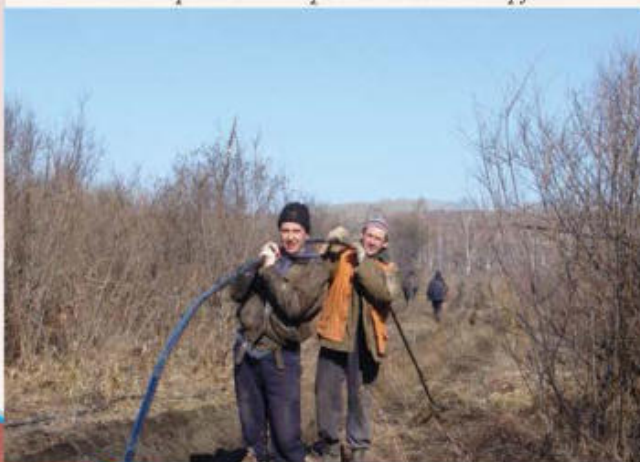
Рабочая бригада на прокладке ВОЛС. Монтажники Е. В. Войлошиков и М. В. Елисейкин
