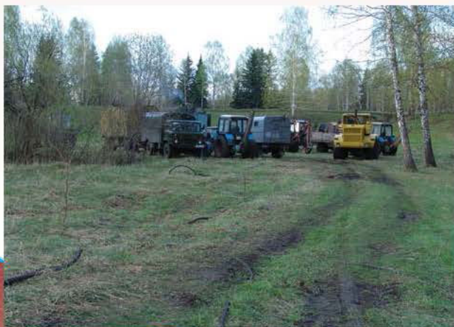
Прокладка ВОЛС мехколонной
