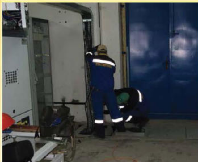
Строительство ВОЛС Юрга-500, подстанция Абразивная-110. 2012 г.
