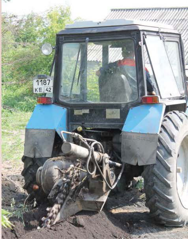
Работа кабелеукладчика
