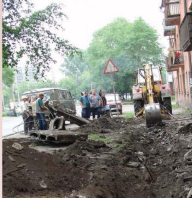
Строительство телефонной канализации
