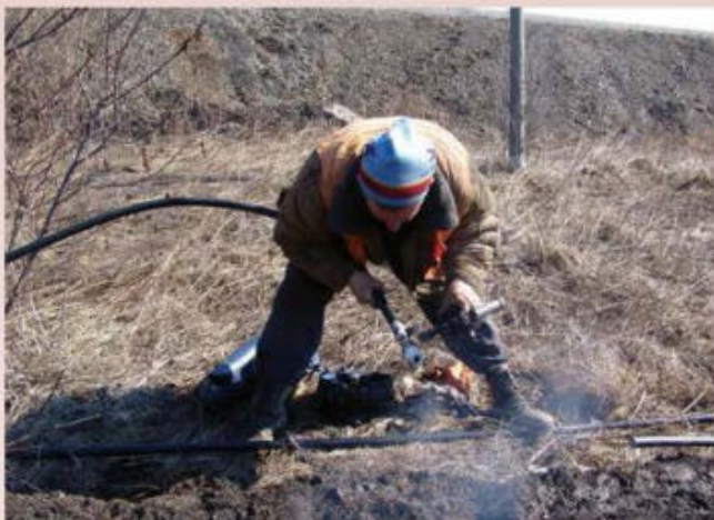
Монтаж кабеля. М. В. Елисейкин
