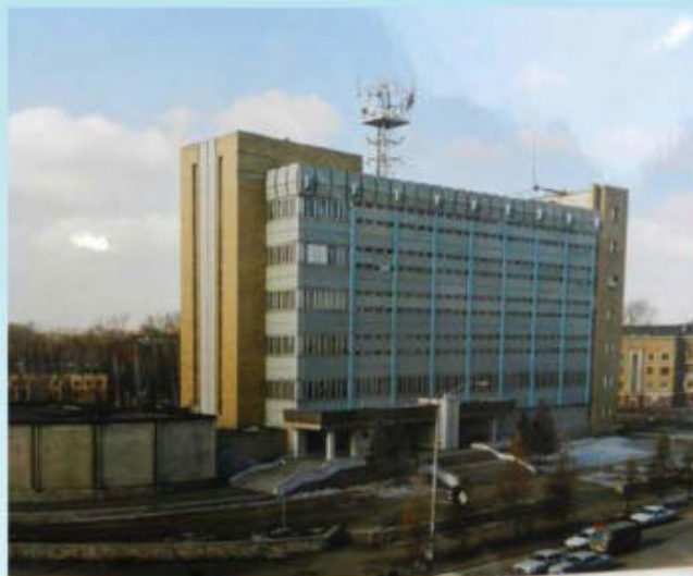
Здание Кемеровской городской телефонной сети
