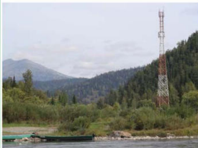
АМС (антенно-мачтовое сооружение) «МегаФона» в одном из отдаленных поселков Кузбасса
