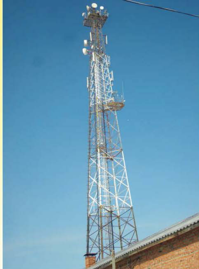
Строительство радиорелейной линии связи
