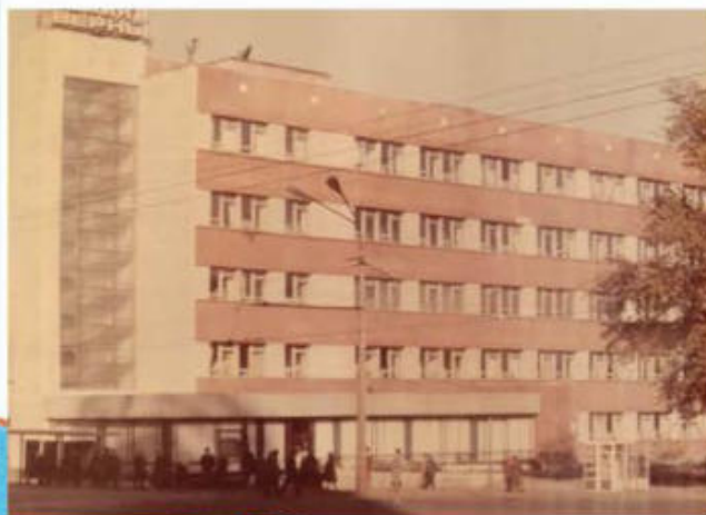
Здание Кемеровской междугородной телефонной станции. 1979 г.
