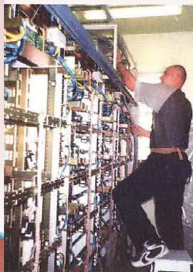
Монтаж оборудования СС-08. Благовещенск
