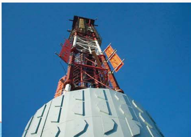
Антенна СЕРВ-24-Г для вещания ТВ-программ Губернского канала
