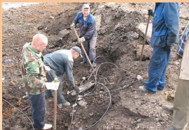
Ремонт линии связи
