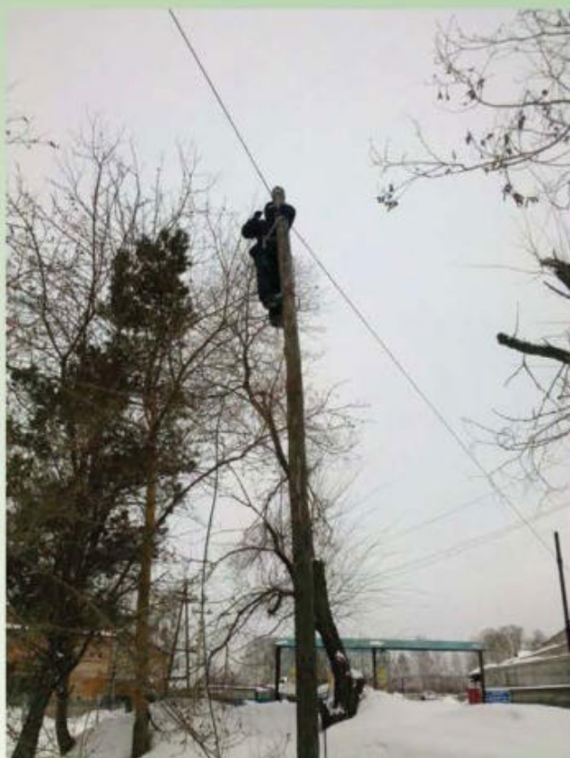
Монтажник кабельной сети
